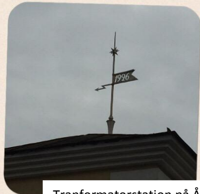
Tranformatorstation på Åsgatan Brunskog/ Westhol
